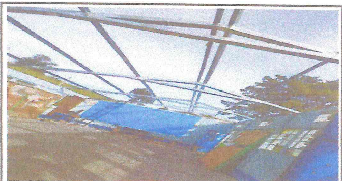
Foto 4: Colocando estructura metalica
