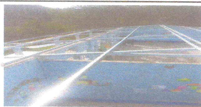
Foto 5: Colocación de estructura metalica
