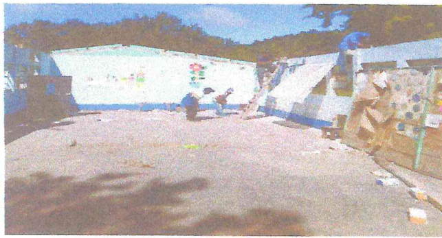
Foto 1: Retirando el techo de la escuela
