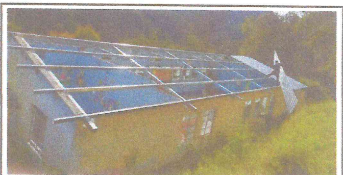
Foto 6: Colocación de lámina
